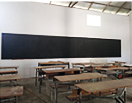
Na de renovatie
