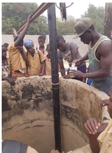
Figuur 3 Waterput uitboren
